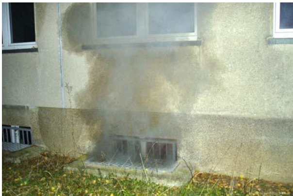
Rauch und Flammen eines Kellerbrandes gefährden rasch alle Mieter im Haus. Foto: Feuerwehr Schwallungen
